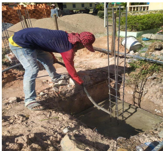
3. コンクリートの流し込み
