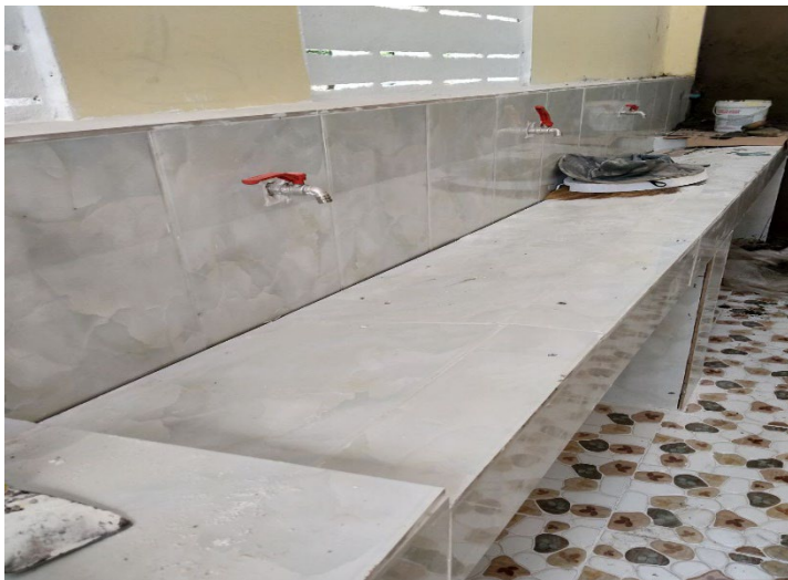
25. 手洗い台のタイル貼り
