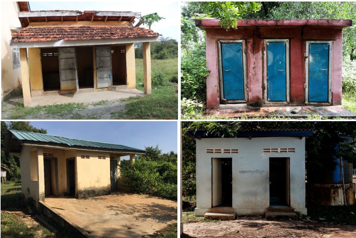
現状のトイレ例
