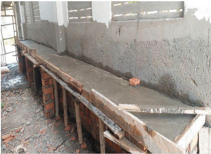
21. 手洗い台工事
