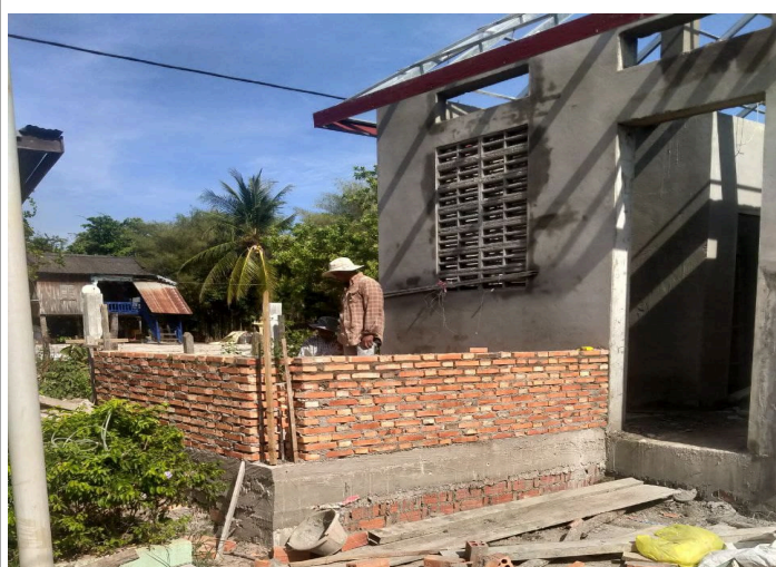
15. 地上ウォータータンク設置
