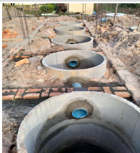
5. 内部浄化槽パイプ設置工事
