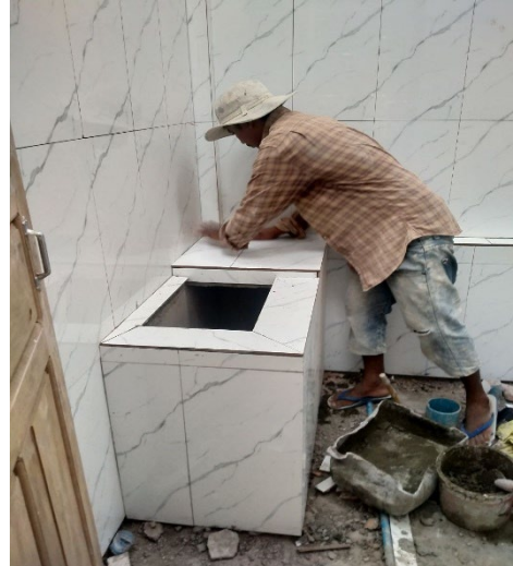
26. トイレ個室のタイル貼り
