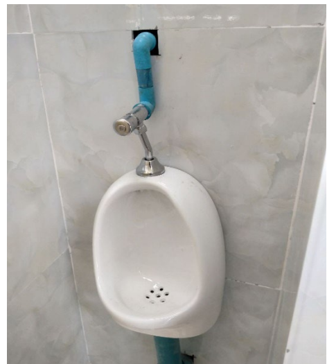
28. 小便器の設置
