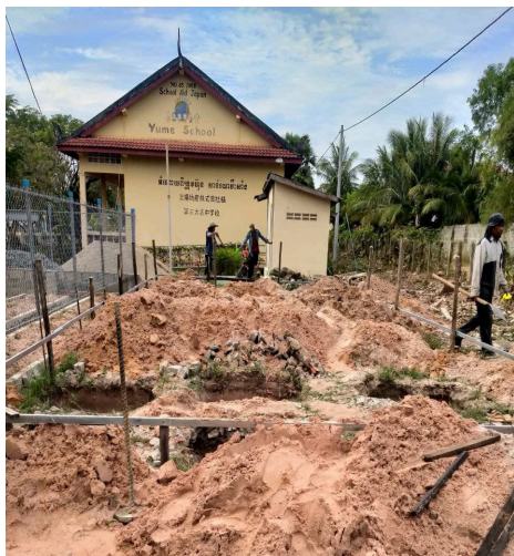
1. 土地整備、支柱の土台基礎工事
