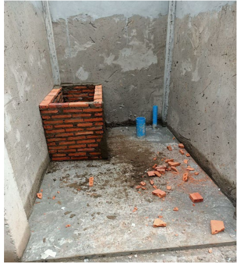
20. トイレ個室の水槽設置
