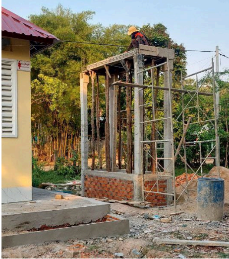
19. タワー型ウォータータンクの設置
