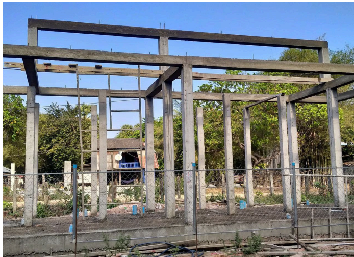
9. 上部構造建設作業
