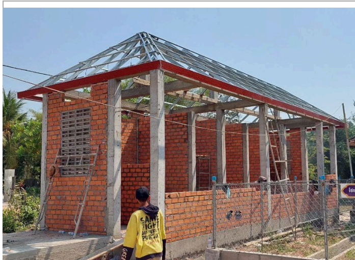
13. 鉄骨屋根の設置
