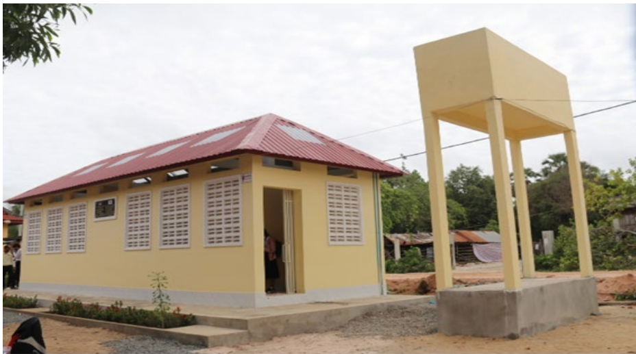
2. 女性トイレ側から
