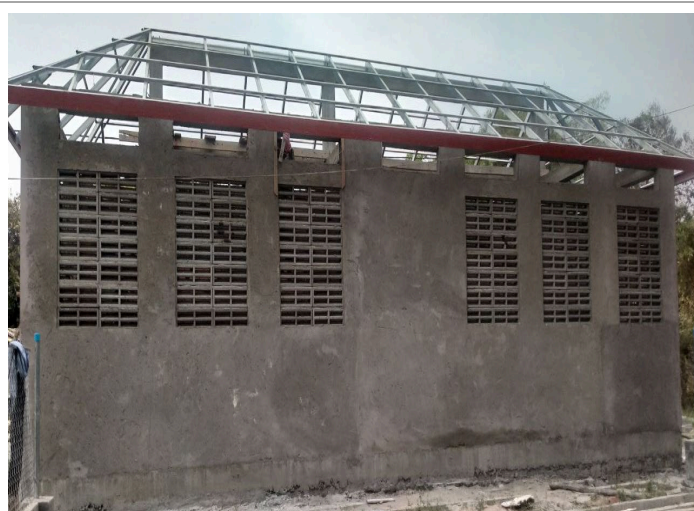
14. 壁の下塗り モルタル
