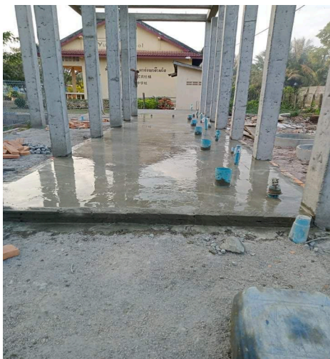
11. 床のコンクリートスラブ工事
