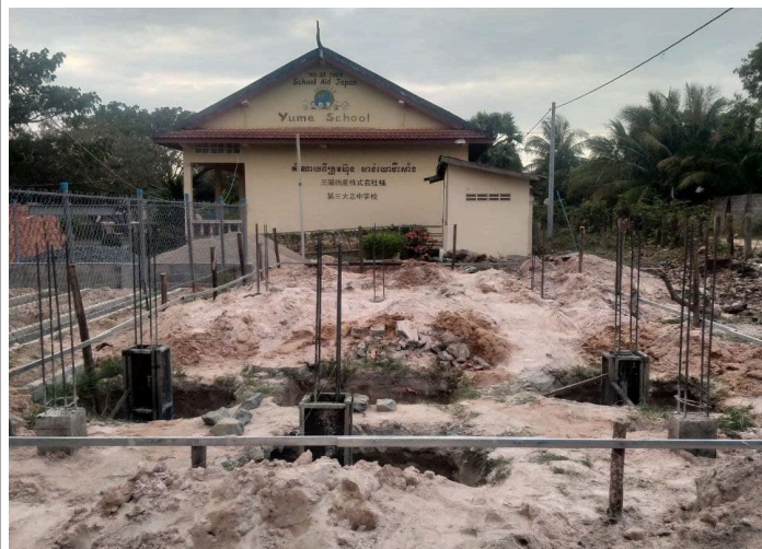
4. 短い支柱の建設
